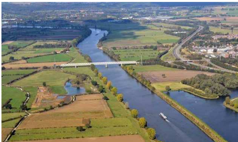
Een luchtfoto van de Maasbrug in Oeffelt. De maatregelen zouden links getroffen moeten worden
